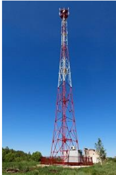
شکل ۲-۵- آنتن‌های فرستنده و گیرنده‌ای که بالای یک برج بلند جهت ارتباطات مستقیم یا بُرد بیشتر قرار گرفته‌اند.
